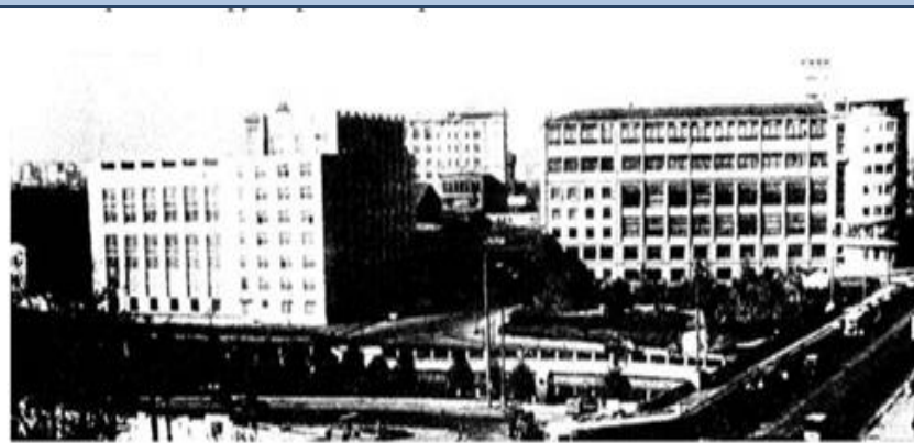
Здание КБ на углу набережной Яузы и улицы Радио. Из собрания М.Саукке
